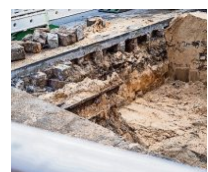
In der Weserstraße im Norden Wulsdorfs ist die Fahrbahn abgesackt. Die Bauarbeiter legten bei der Reparatur alte Straßenbahnschienen frei. Foto: Hartmann
